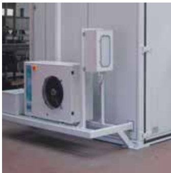
Unità moto condensante installata su basamento antivibrante completa di serbatoio di raccolta del liquido e compressore.
